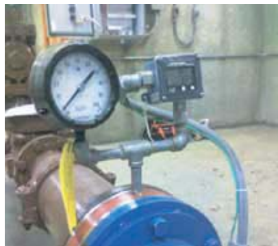
Прибор One Series , установленный на изолирующем кольце для контроля сточных вод
